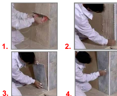
Ejemplo de colocación del Novocanto ® PVC
